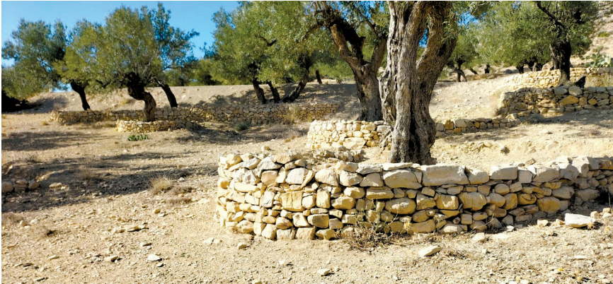
صورة عدد2: جسر بالحجارة ل تخزين مياه الامطار وحماية التربة من الانجراف
